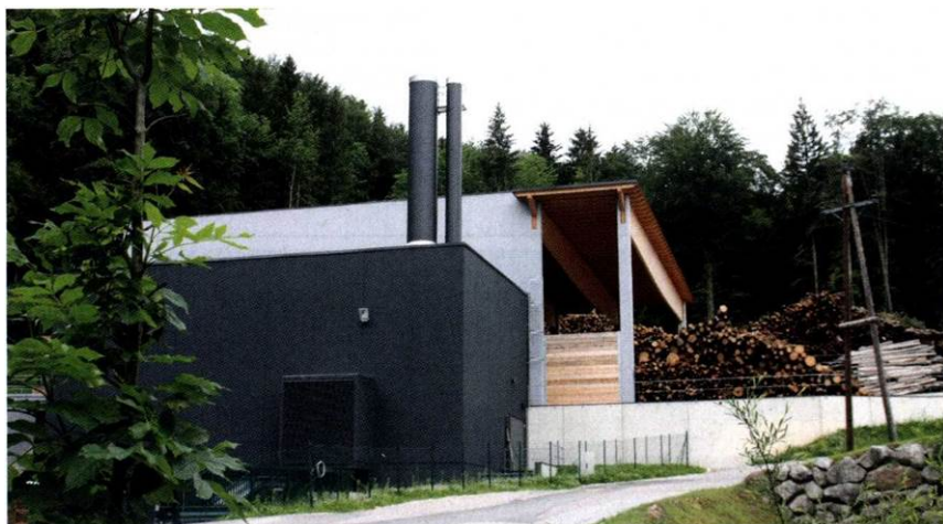
Foto: Heizwerk Fuschl am See
